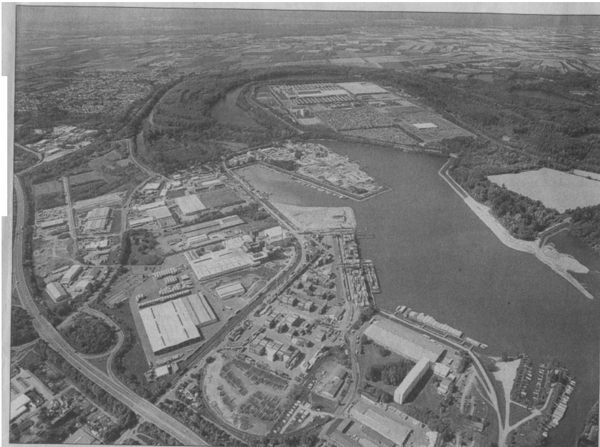
Die Bebauungspläne der Gewerbe- und Industrieflächen nördlich der Bundesstraße 35 (links am Bildrand) werden überprüft und in Logistik-Vorrangflächen verändert. Das hat der Germersheimer Stadtrat gestern Abend beschlossen. Rechts am Bildrand die freie Industriefläche der Insel Grün.
