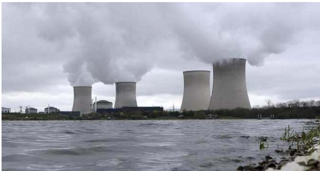
Das französische Kernkraftwerk Cattenom; Foto: Christophe Karaba/Archiv
